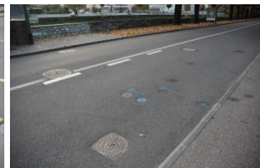
23.10.2015: Bereich neben via Ferri 13 Schachtdeckel: viele kleine besonders lärmige Deckel (Wasserversorgung), eine Reihe unter dem linken Rad und noch weitere...
