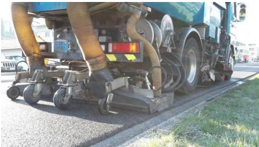
Abb. 15 Reinigungsverfahren Rotoplast mit anschliessendem Absaugen.
