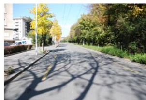
Teststrecke Prilly / VD, Zustand am 21.10.2015
