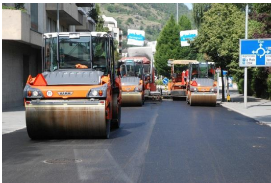
Einbau 1. Etappe auf der gesamten Breite
