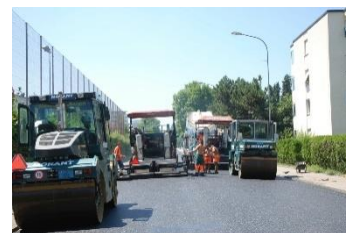
Einbau auf der gesamten Breite
