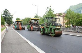
Teststrecke Lugano / TI: Abschnitt via Balestra – via Madonnetta (Nachteinbau) Abschnitt via Madonnetta – via Ferri (Nachteinbau). Wartezeit damit die PmB-Emulsion trocknen kann.
