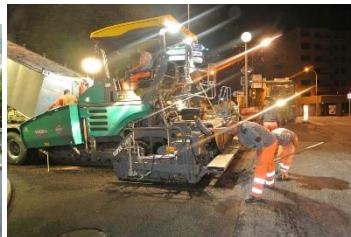
Teststrecke Lugano / TI: Abschnitt via Balestra – via Madonnetta (Nachteinbau) Abschnitt via Madonnetta – via Ferri (Nachteinbau). Wartezeit damit die PmB-Emulsion trocknen kann.
