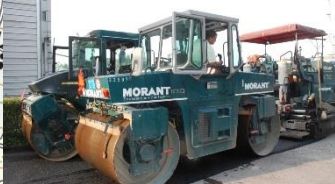
Probereinbau auf Mischgutaufbereitungsanlage MOAG in Mörschwil
