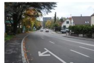
Teststrecke MuttENZ / BL, Birsfeldenstrasse, Teil 2, Zustand am 16.10.2015
