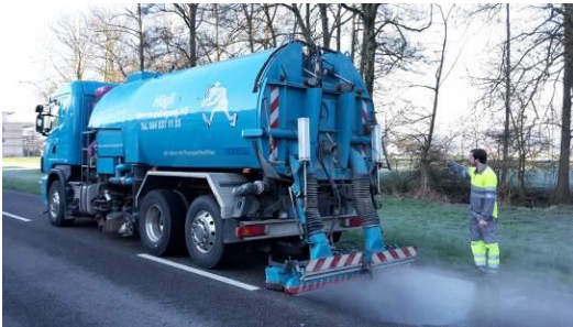
Abb. 14 Reinigungsverfahren Sprühbalken mit anschliessendem Absaugen.
