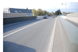
Teststrecke Yverdon / VD, Zustand am 21.10.2015
