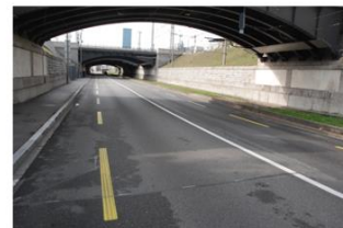
Teststrecke Riehenstrasse / BS, Zustand am 16.10.2015
