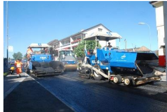
Einbau auf gesamter Breite
