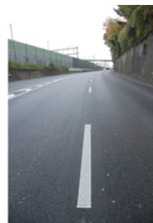
Teststrecke Muttetz / BL, Birsfeldenstrasse, Teil 1, Zustand am 16.10.2015
