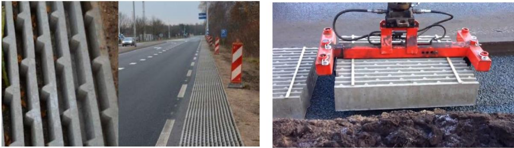
Abb.9 Diffraktoren, verlegt, Verlegewerkzeug
