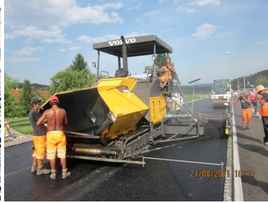
Einbau auf voller Breite mit einem Fertiger
