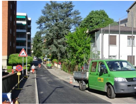
Vorbereitungen für den Probeeinbau in via alla Roggia in Viganello
