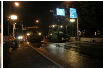
Teststrecke Lugano / TI: Abschnitt via Balestra – via Madonnetta (Nachteinbau) Abschnitt via Madonnetta – via Ferri (Nachteinbau). Wartezeit damit die PmB-Emulsion trocknen kann.
