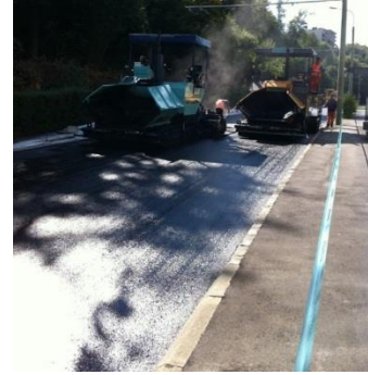
Einbau auf gesamter Breite
