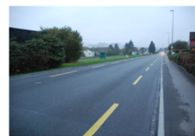
Teststrecke Birmenstorf / AG, Zustand am 16.10.2015
