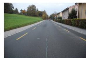
Teststrecke Muri / BE, Zustand am 16.10.2015
