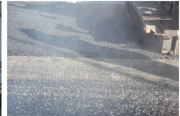
Armierungsnetz S+P Glasphalt im Bereich der Längsfuge
