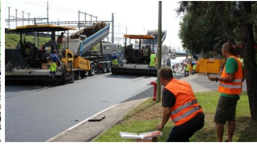
Teil 1: Einbau auf gesamter Breite
