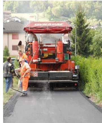
Probereinbau Eyholz, Cherstrasse
