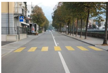
Zustand am 23.10.2015 – Blick von via Ferri Richtung Norden.
