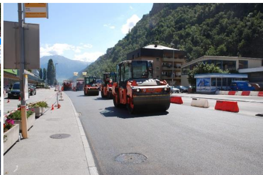
Einbau Etappe auf halber Fahrbahnbreite
