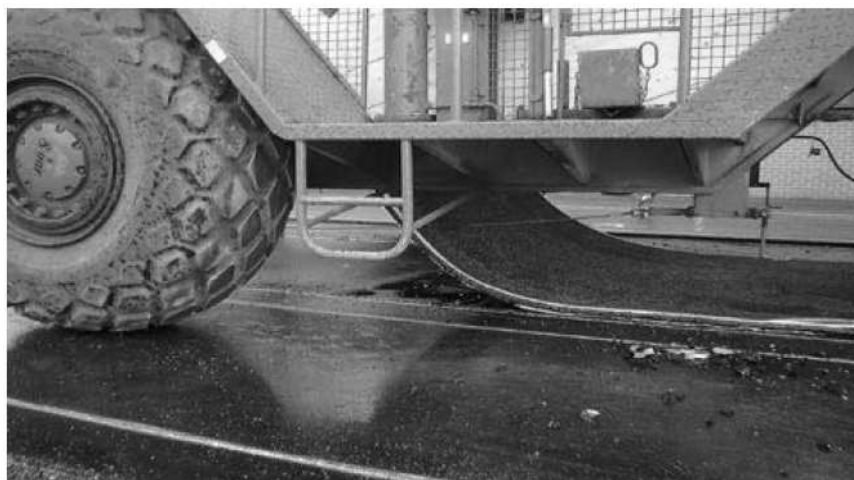
Fig. 10 Mise en place d'un revêtement Rollpave [14].
