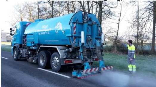
Abb. 5: Reinigungsverfahren Sprühbalken mit anschliessendem Absaugen
