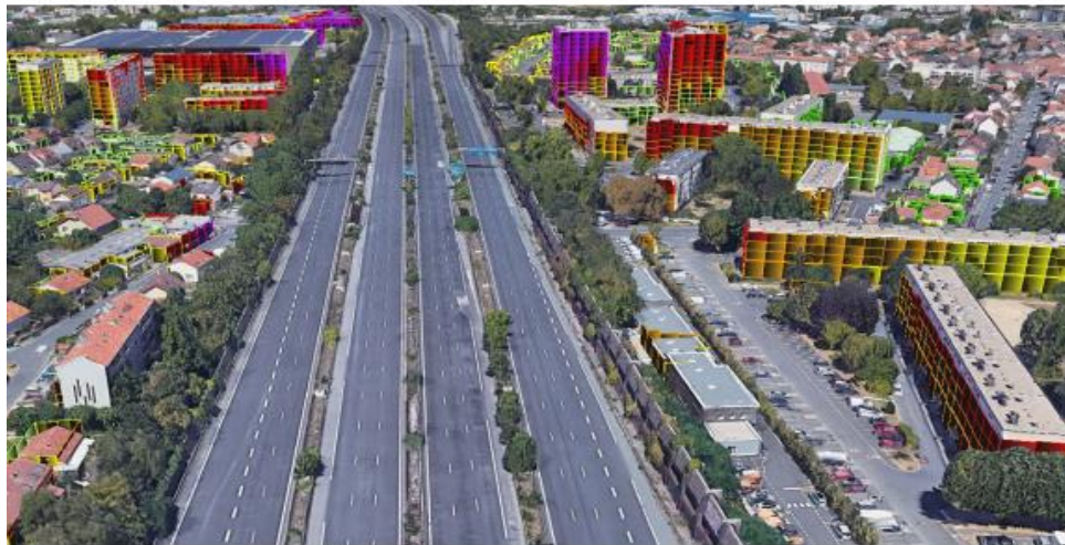
Figure 4 : Cartographie du bruit routier (selon l'indicateur Lden) généré par l'autoroute A6 en façade des bâtiments de l'Hay-les-Roses un an après la pose du revêtement antibruit
